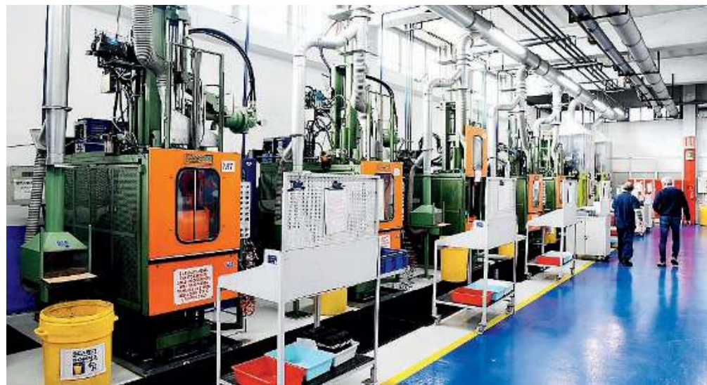
Rifatta. Una parte dello stabilimento rifatta in questi ultimi anni. I lavori sono in corso in gran parte della fabbrica
