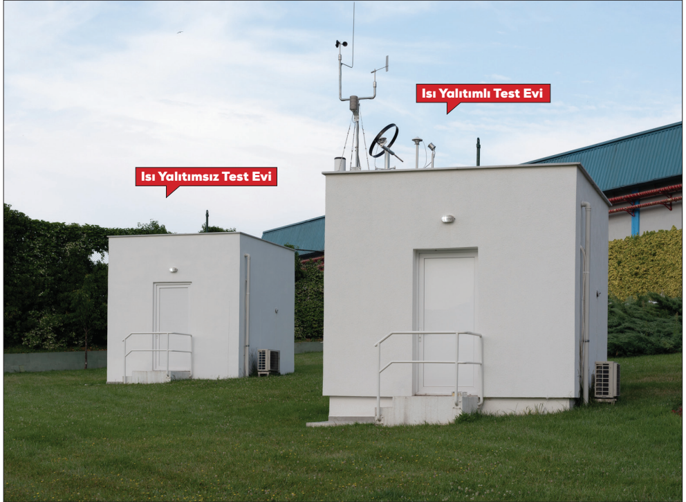
Dalmaçyalı İleri Isı Yalıtım Sistemi ile ısı yalıtımı yapılmış ev ve ısı yalıtımsız ev
