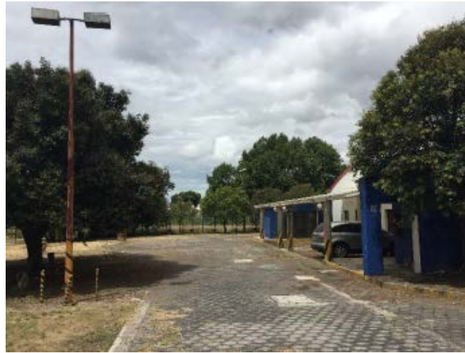
Terreno e inmueble
