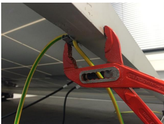
Figuur 8: Aardingsklem aanknijpen
