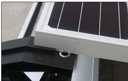
Figuur 1: Aardingsring onder het paneel.
