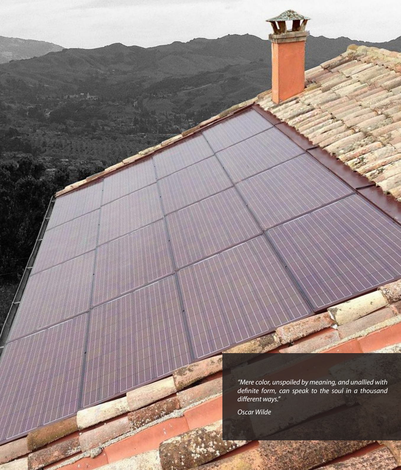
Détail du cadre special BIPV (Solrif®)
