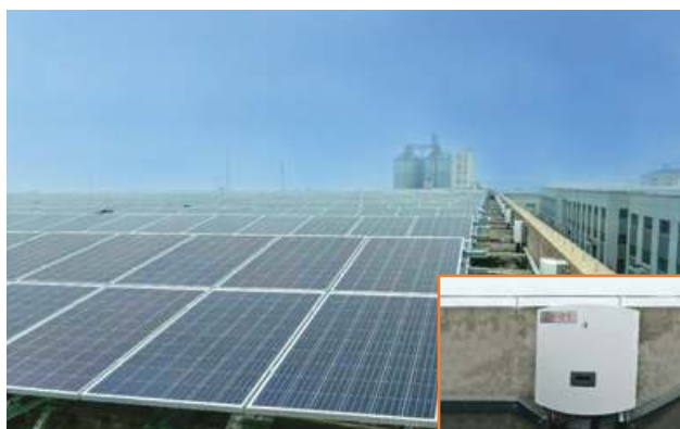
Changzhou Vaillant 2MW
