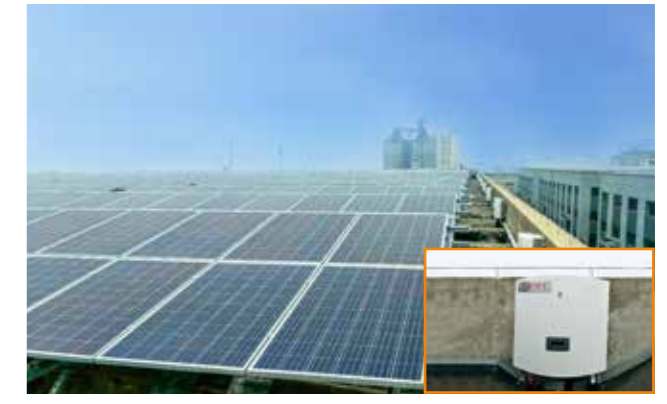
Changzhou Vaillant 2MW
