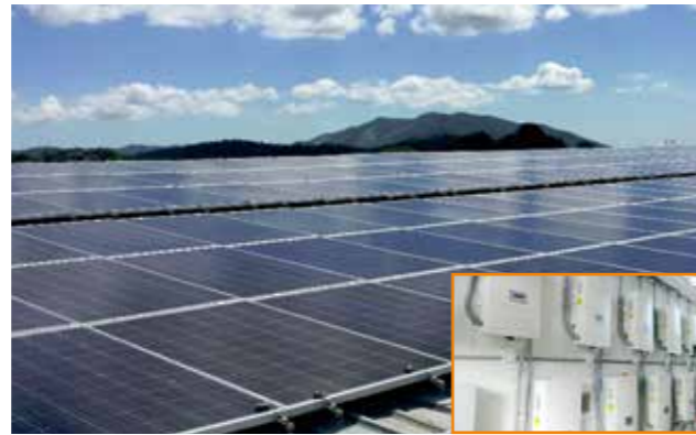
Panama UGE Cochez 3.4MW
