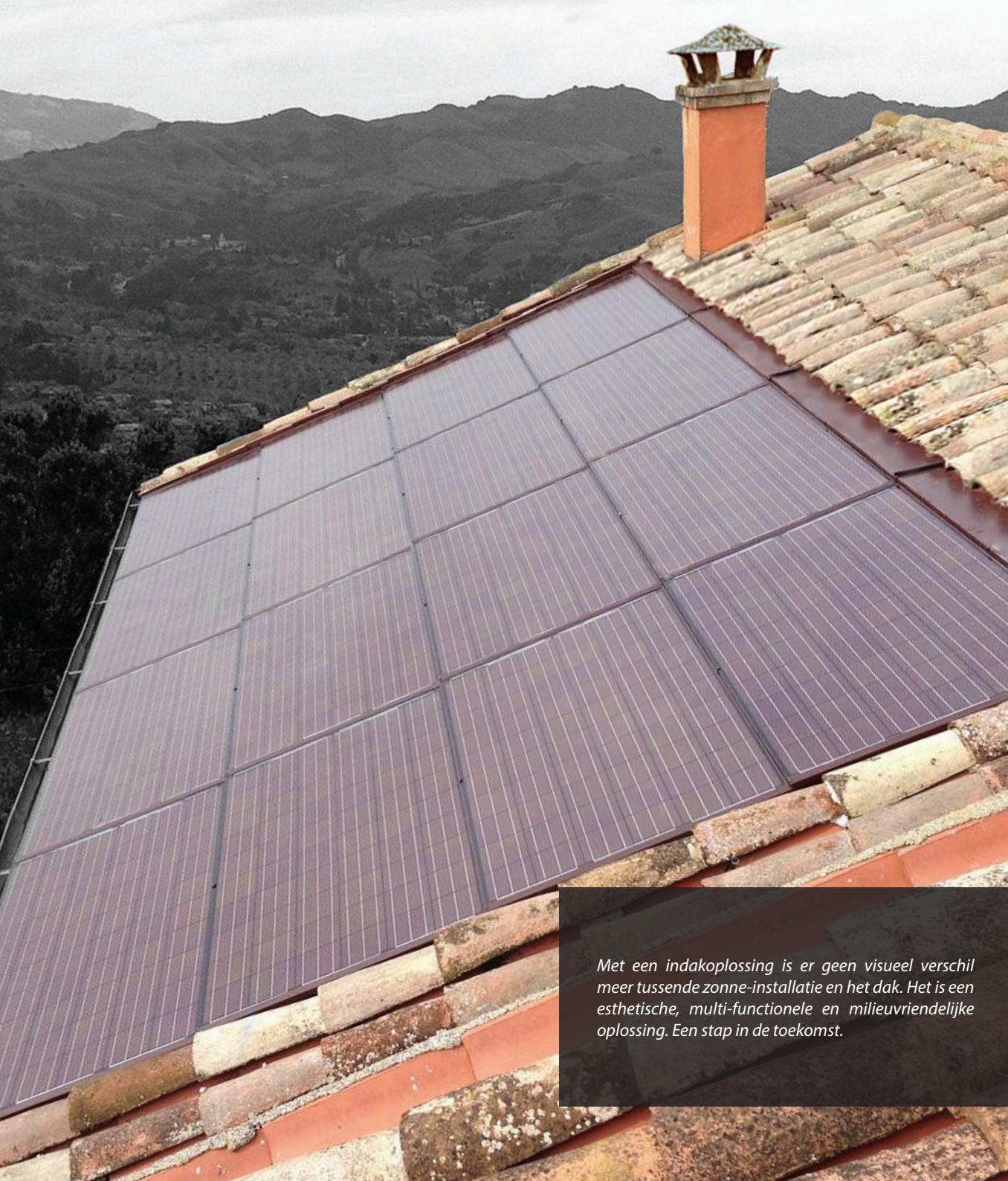
Detail van het BIPV (Solrif®) kader
