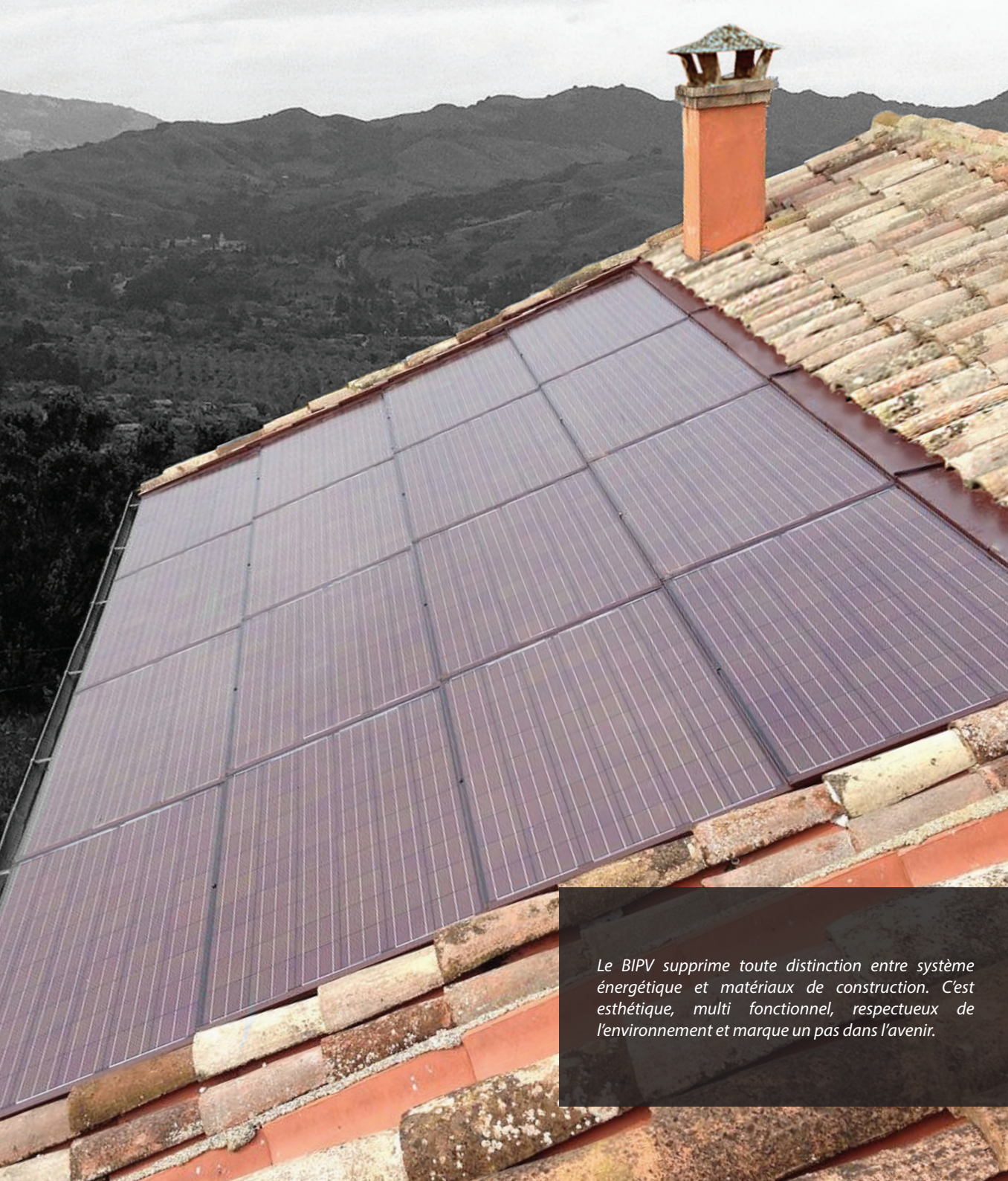
Détail du cadre special BIPV (Solrif®)
