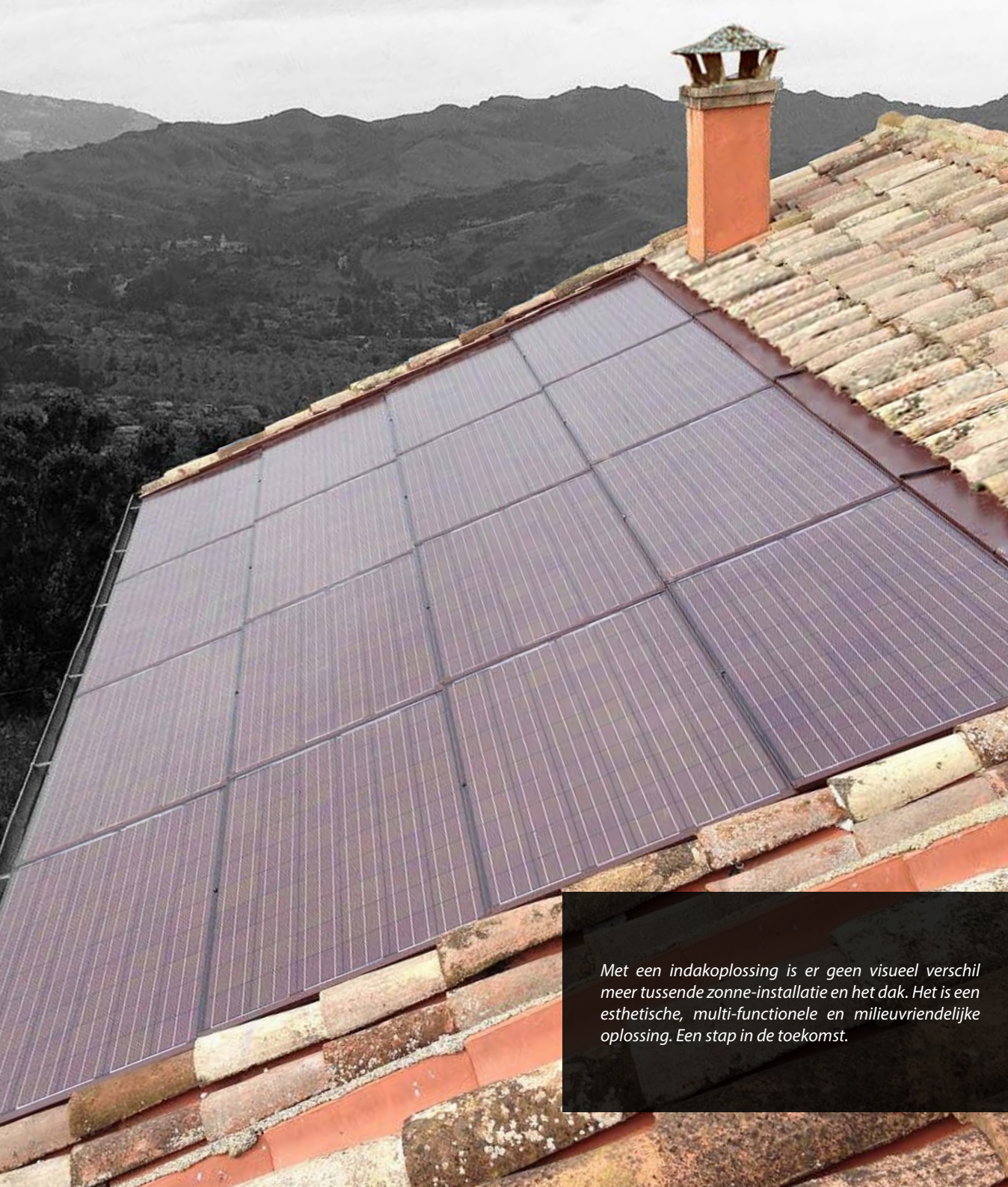
Detail van het BIPV (Solrif®) kader
