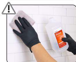
**ÉTAPE 3 :** Essuyer la surface avec un mélange de 50 % d'alcool isopropylique et 50 % d'eau et tapoter pour la sécher.
