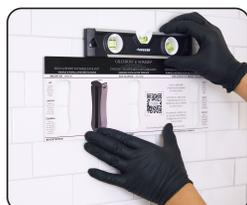
**ÉTAPE 4 :** Utiliser le modèle d'installation pour identifier l'emplacement de montage du support. Utiliser un niveau pour vérifier que le modèle est bien horizontal, puis placer le ruban adhésif sur les 4 coins pour accrocher le modèle au mur dans la position souhaitée.
