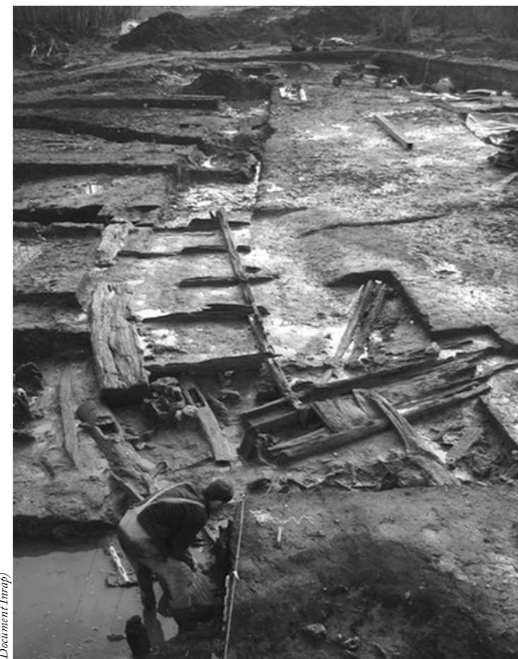
Substructions d'un ponton et d'une passerelle du X e siècle, à Pineuilh (Gironde), découverts lors des travaux de la déviation de Sainte-Foy-la-Grande en 2003.
