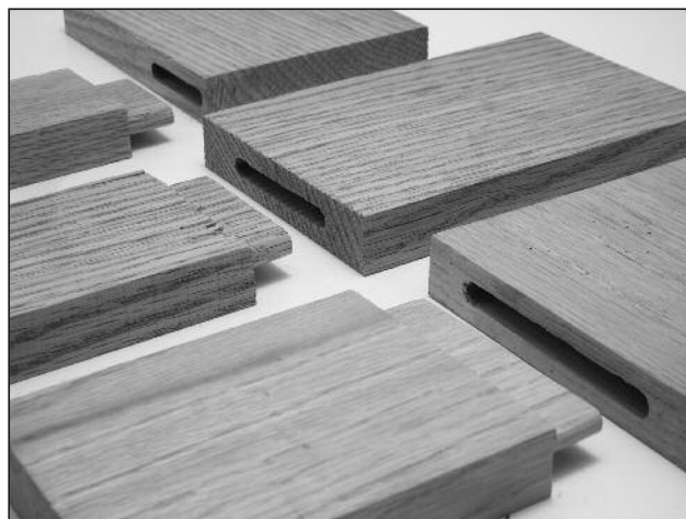
Exemples d'assemblages à mortaise et tenon
