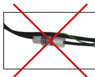
Posición incorrecta del depósito de condensados
