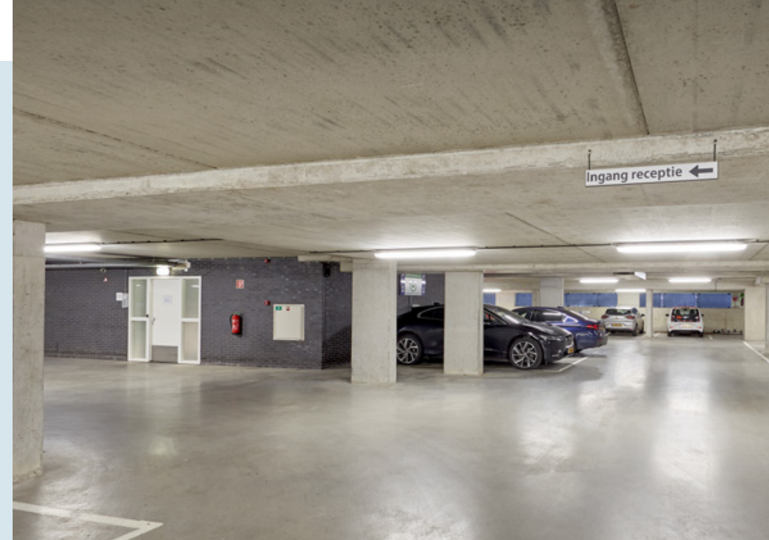
Parkeergarage onder het gebouw
