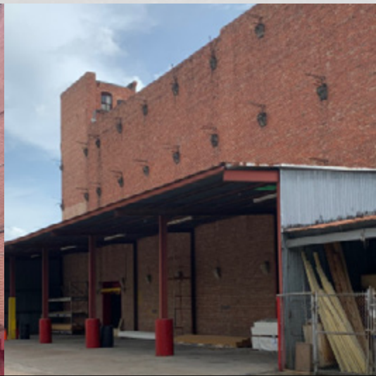
Bldg. 5 Exterior N. Elevation
