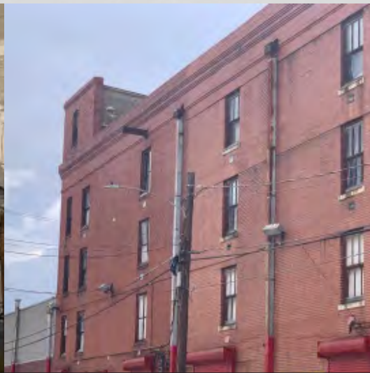
Bldg. 5 N. Live Oak Elevation
