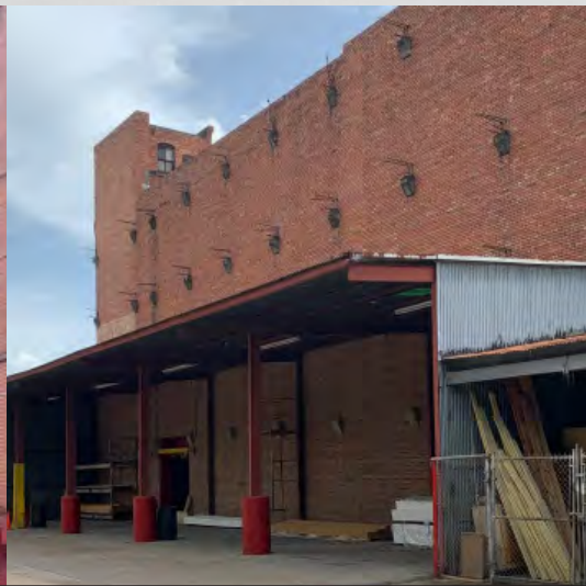
Bldg. 5 Exterior N. Elevation
