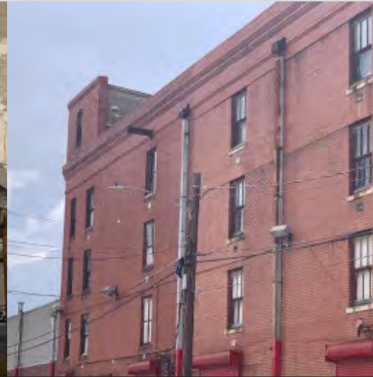
Bldg. 5 N. Live Oak Elevation
