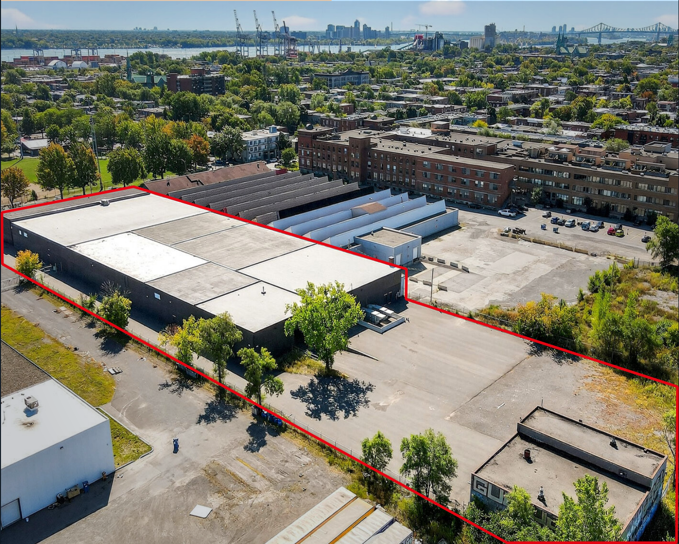
TERRAIN ET DEUXIÈME BÂTIMENT
