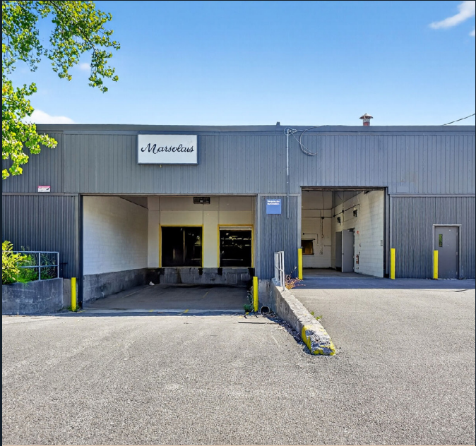
EXTÉRIEUR DE LA PORTE DU QUAI DE CHARGEMENT
