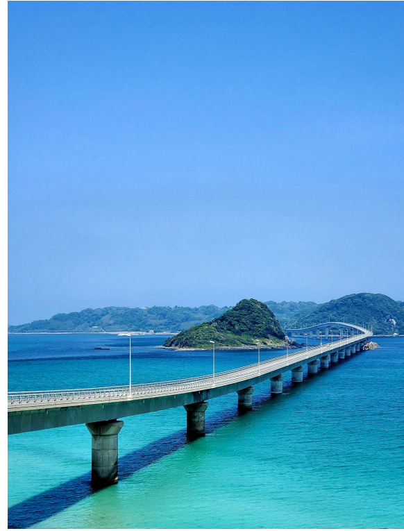
下关市的角岛大桥（Tsumoshima Bridge）
