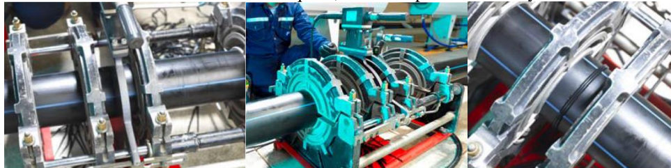
Fase 1: Pre Calentamiento Fase 2: Calentamiento Fase 5: Soldadura con elementos a presión
