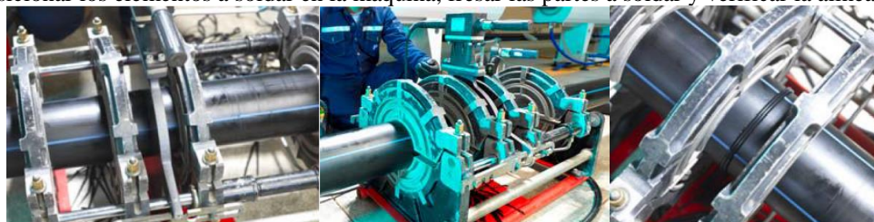
Fase 1: Pre Calentamiento Fase 2: Calentamiento Fase 5: Soldadura con elementos a presión
