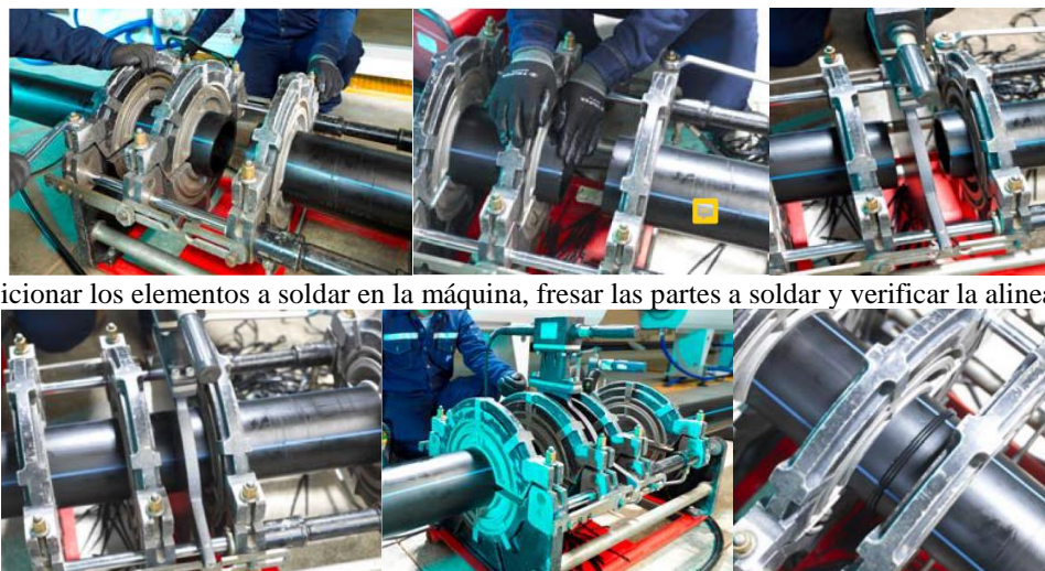
Fase 1: Pre Calentamiento Fase 2: Calentamiento Fase 5: Soldadura con elementos a presión
