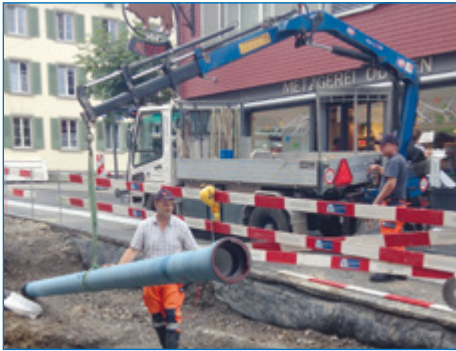
Sanierung Dorfstrasse Schindellegi
