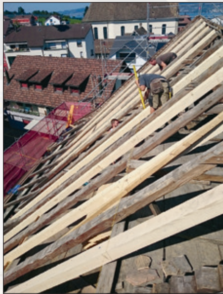
Zur Verstärkung der Traglast werden zusätzliche Balken eingezogen.
