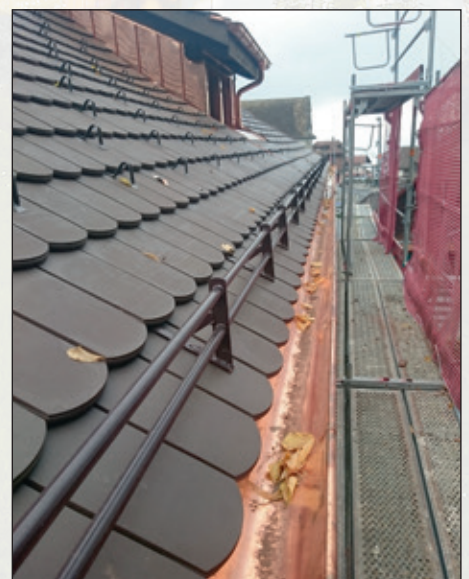
Nach Fertigstellung der Sanierungsarbeiten: Aus Alt wird Neu!
