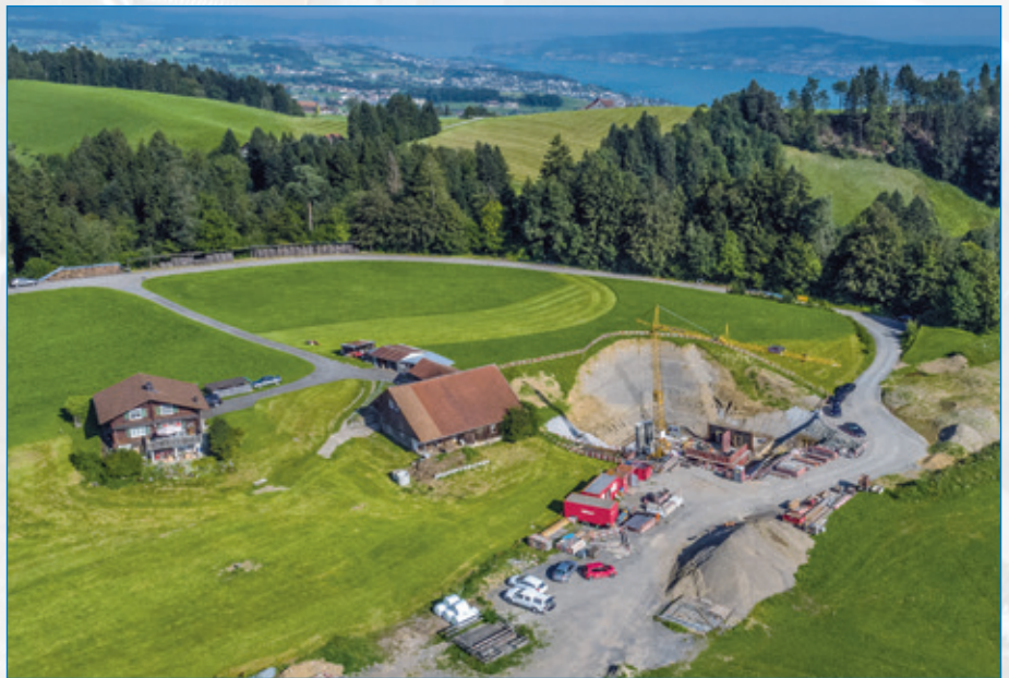
Luftaufnahme Geissboden, Bauarbeiten Aufbereitungsgebäude.
