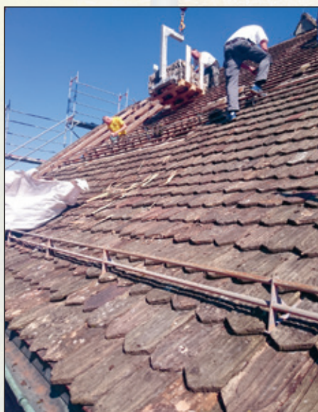
Die renovierungsbedürftige Dachkonstruktion wird abgedeckt.
