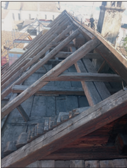
Das in grosser Arbeit freigelegte Dach ist bereit zur Sanierung.
