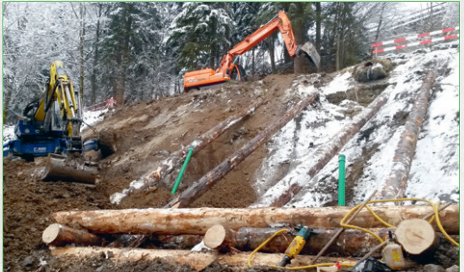
Der Hangrutsch am Kanalweg wird im kommenden Frühjahr nach dem Vorbild der Hangverbauung 2015 saniert werden.
