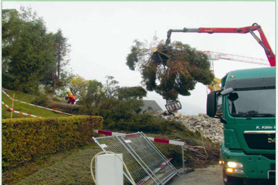
Oben: Kranarbeiten zur Gehölzentfernung, unten: Astentfernung auf Platz
