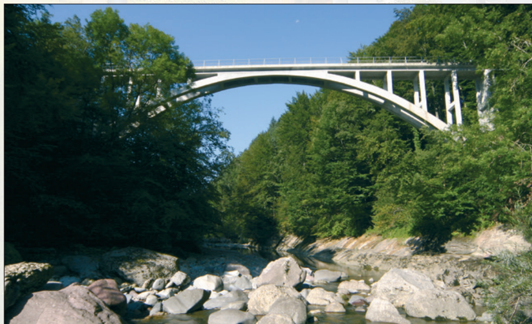
Die Scheerenbrücke über die Sihl bietet einen imposanten Anblick
