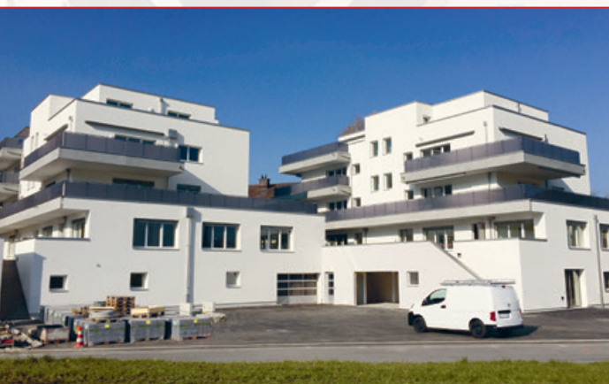
Neubau Fällmisstrasse 64+66, Wilen
