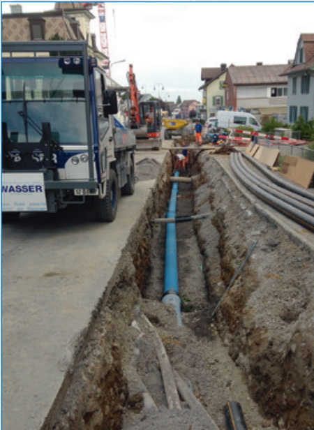
Oben: Transportleitung Dorfstrasse, unten: Zusammenschluss Sternenbrücke
