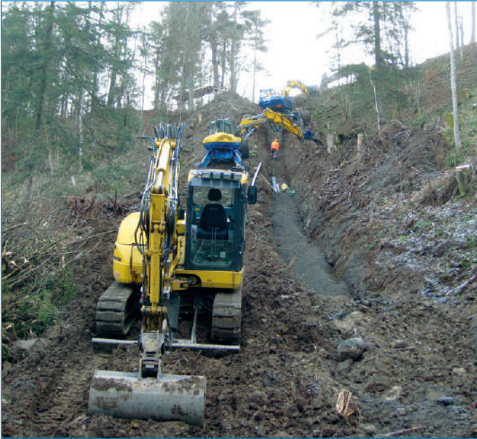
Oben/unten: Leitungsbau vom Geissboden zur Sihl, rechts: Transportleitung dem Kanalweg entlang nach Schindellegi
