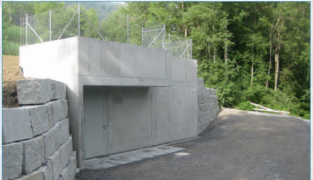
Das fertiggestellte Reservoir Sihl am Kanalweg in Schindellegi.
