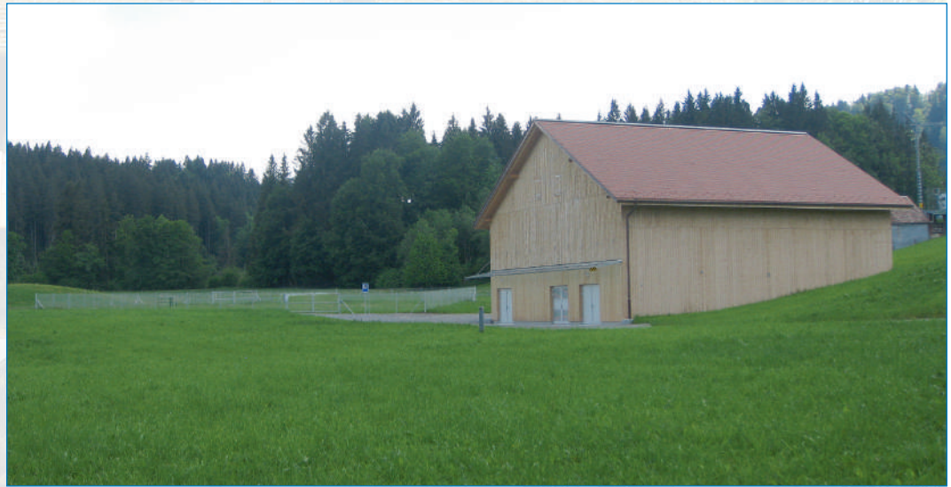
Das fertiggestellte Wasseraufbereitungs-Gebäude mit den Brunnen in der eingezäunten Schutzzone 1.
