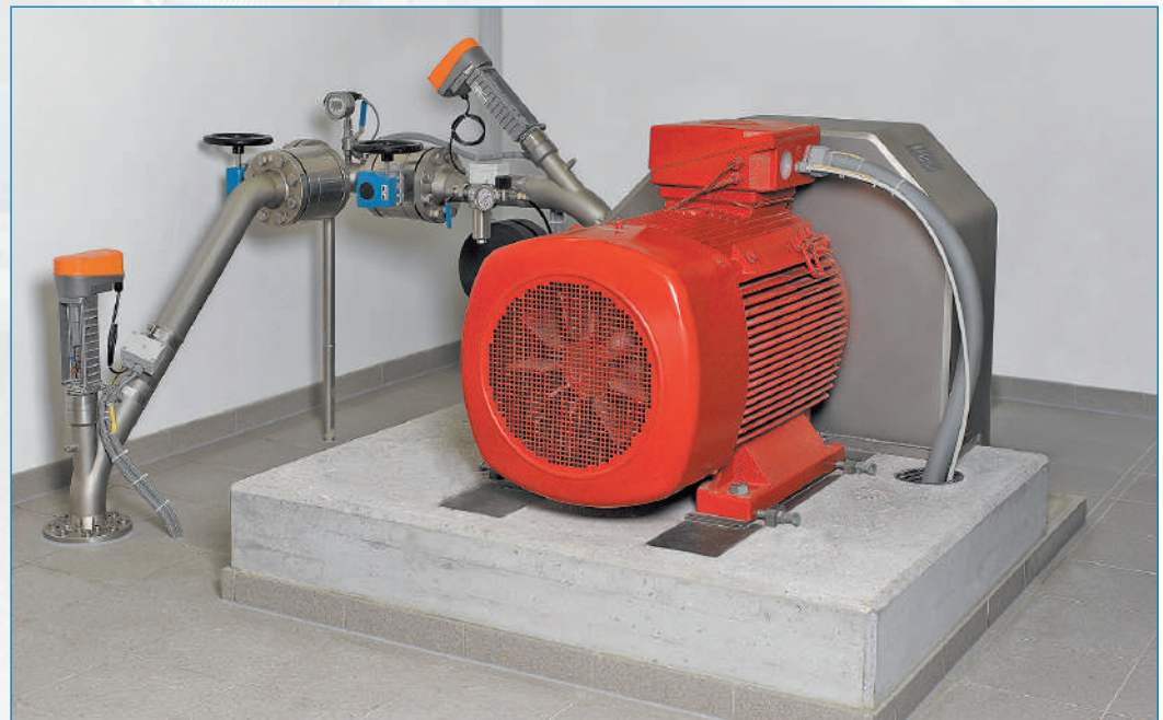
Mit einer ähnlichen Turbine werden die beiden Trinkwasserkraftwerke der Korporation Wollerau ausgestattet sein.
