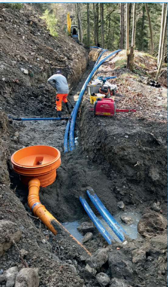
Grabarbeiten Sanierung Quelleitung Stollen, Schindellegi.
