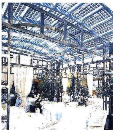
Energia. La cupola fotovoltaica che copre il ristorante del Lefay resort & Spa Lago di Garda
