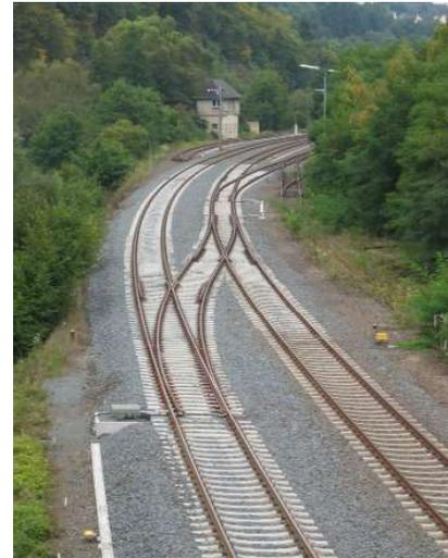
Bild 4.58 Weichenverbindung aus IBW und ABW in der Überhöhung
