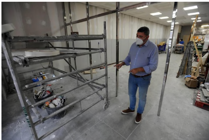
Oscar Castro, administrador de la entidad, muestra el avance de las obras en el mes de octubre. Foto: PEDRO PUIG
