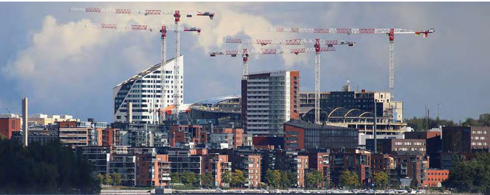
Tampere aréna vo výstavbe
