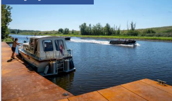
Aanlegsteiger aan de Schie
