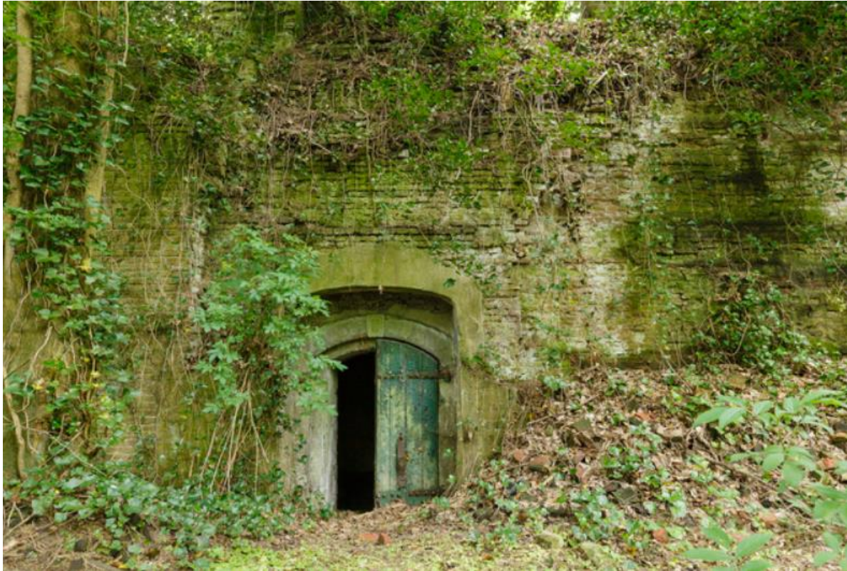
Ingang wachthuis op Fort Hinderdam Foto: Martin Stevens
