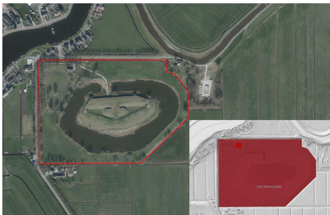
Begrenzing Fort Waver-Amstel: 10,36 ha L02.01 Fortterrein, 0,06 ha E01.01 Overig gebouw en erf
