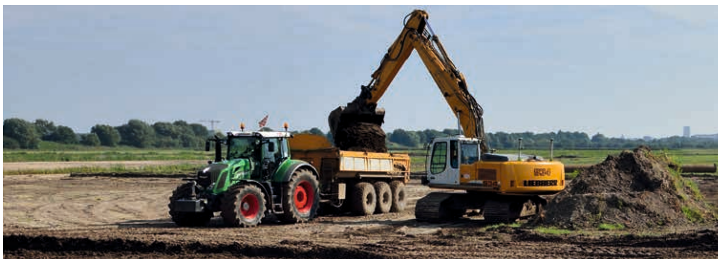
Afgraven van voedselrijke grond. Excavating nutrient-rich soil.
