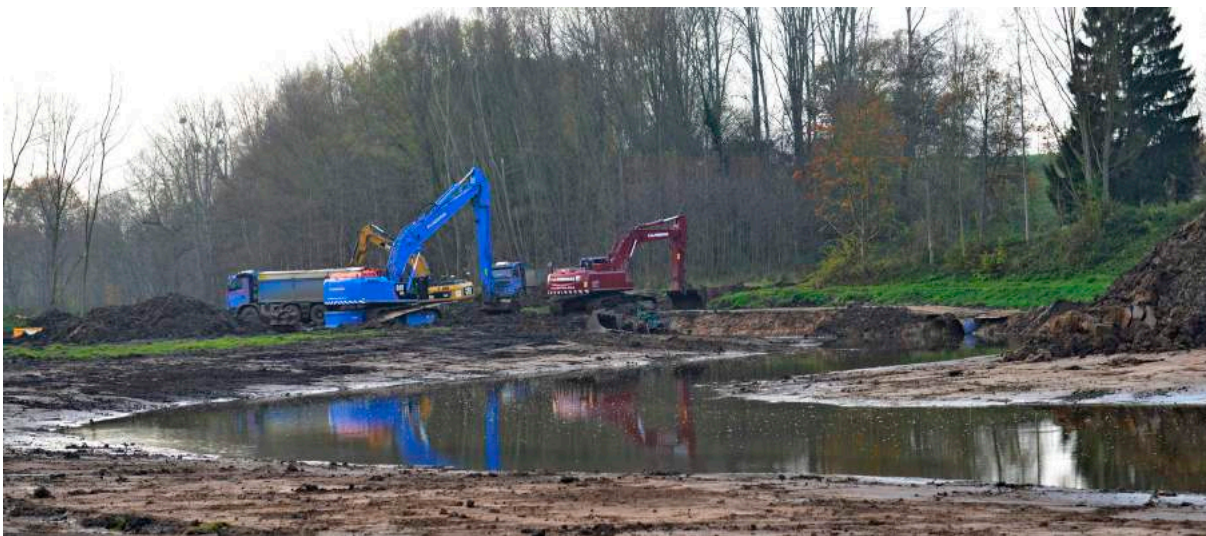
In 2014/2015 is een hermeanderingsproject van de Geleenbeek uitgevoerd.
