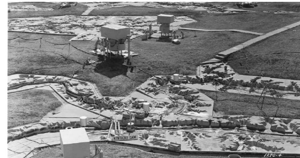
Waterways Experiment Station in Vicksburg, ca. 1950. Bron: Eigen Collectie Model van de Mississippi, ca. 1950. Bron: Eigen Collectie
