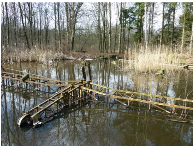
De inlaatduiker aan het Vollenhove Kanaal, op de voorgrond de regelvijver. Restanten van modellen herinneren aan het functioneren als laboratorium.
