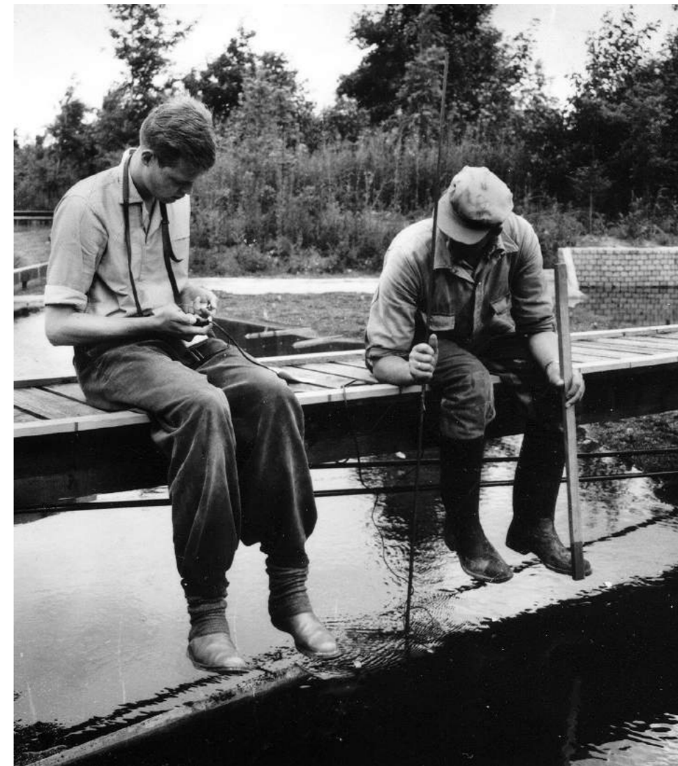
Metten van de stroomsnelheid, jaartal onbekend. Bron: archief Waterloopkundig Laboratorium
