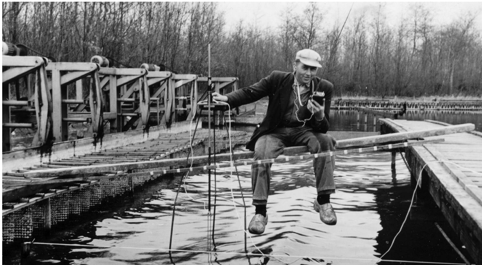
Het meten van de golfhoogte, jaartal onbekend. Bron: archief Waterloopkundig Laboratorium
