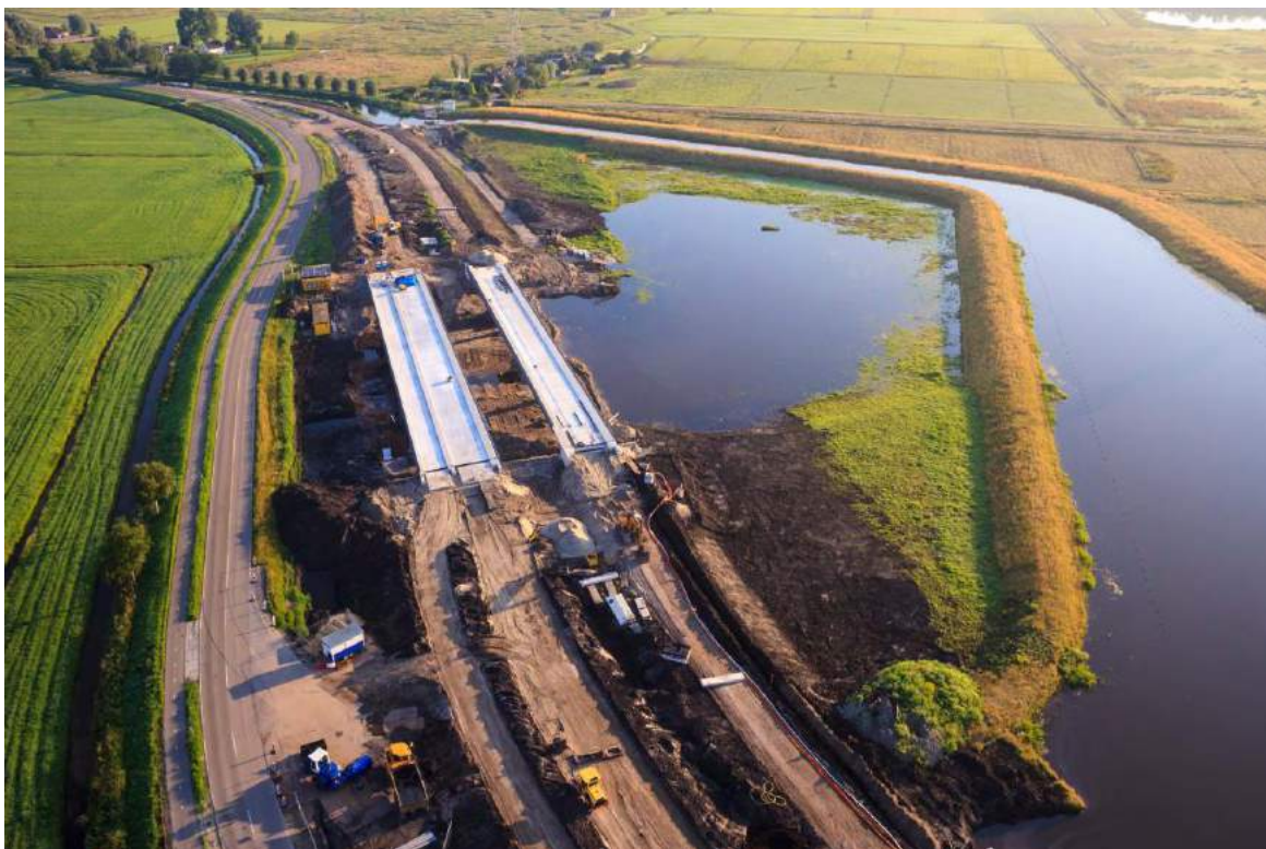
Aanleg natuurverbinding Ankeveen-Naardermeer.
