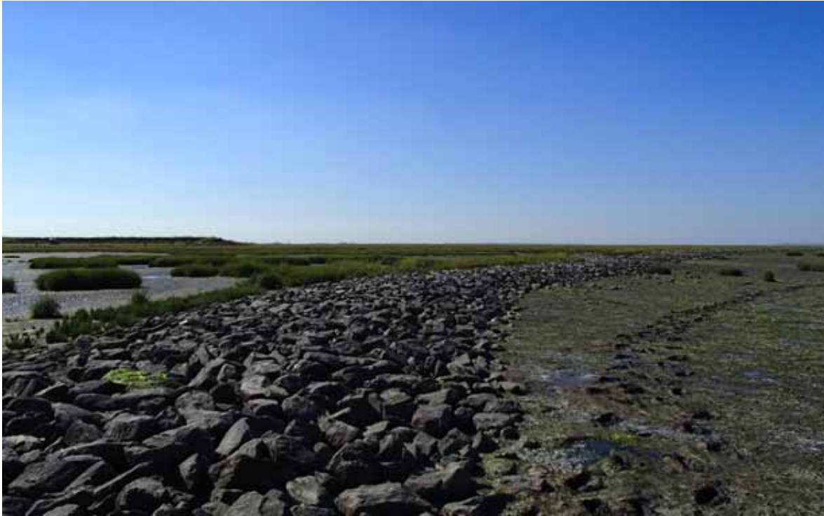
Figuur 4.1. Stenen dam bij Rattekaai. Landwaarts van de steenbestorting zijn pollen Engels slijkgras te zien, maar ook nog grote delen onbegroeid. Zeewaarts van de dam ligt een laag zeesla.
