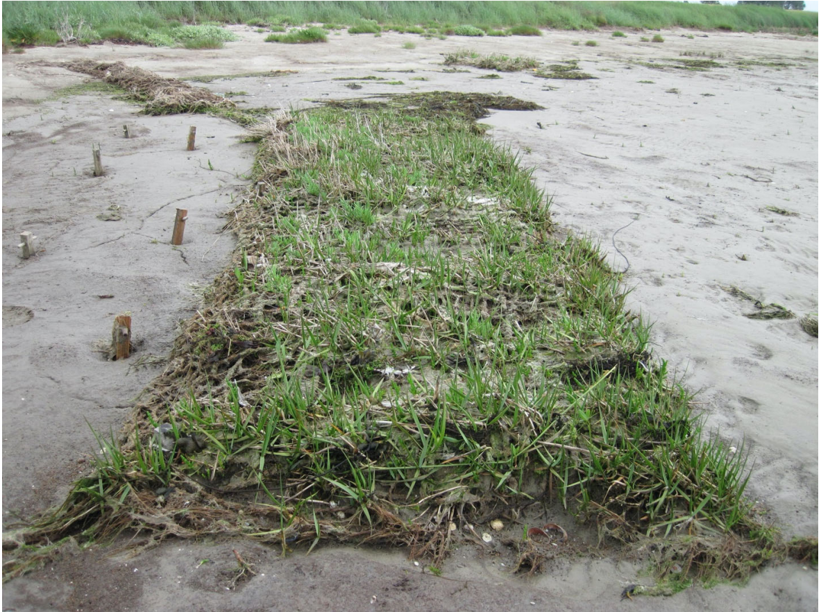
Figuur 4.3. Engels slijkgras groeit goed in geotextiel van kokosvezel bij het schor van Sint Annaland (Oosterschelde, noordelijk t.o.v. het Verdrongen Land van Zuid-Beveland).
