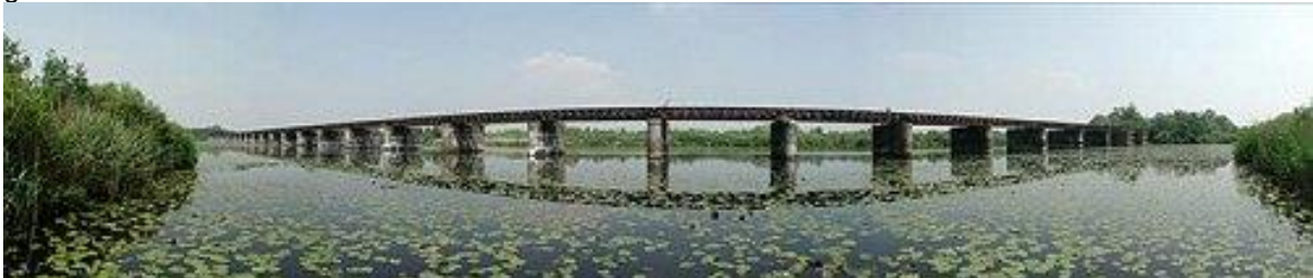
De spoorbrug midden door de Moerputten
