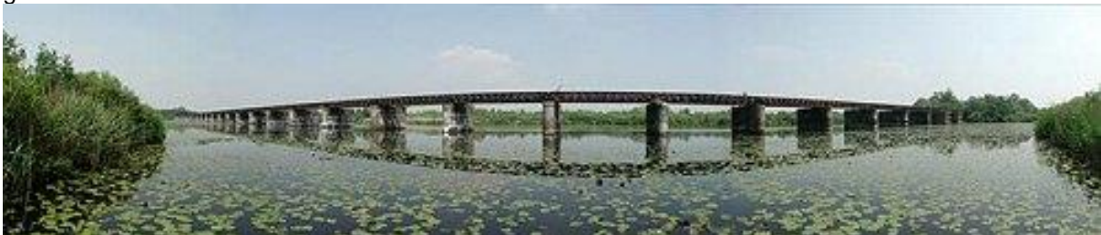
De spoorbrug midden door de Moerputten
