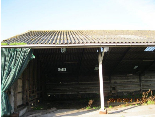
De open loods achter de schuur is gebouwd in 1988.
