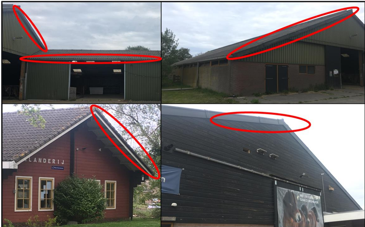
Figuur 2.3. Potentiële nestgelegenheid voor gierzwaluwen. Ruimte onder de daklijsten van v.l.b.n.r.o.: de opslagschuur en potstal (links), potstal, woonboerderij* en activiteitenschuur*.
