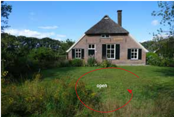
voortuin: ruimte voor voorgevel open houden, gevel in beeld, hier geen hagen (Kruisdijk 7)
