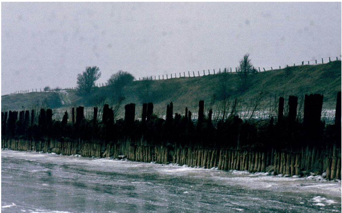
Palenbeschoeiing halverwege de jaren '80
