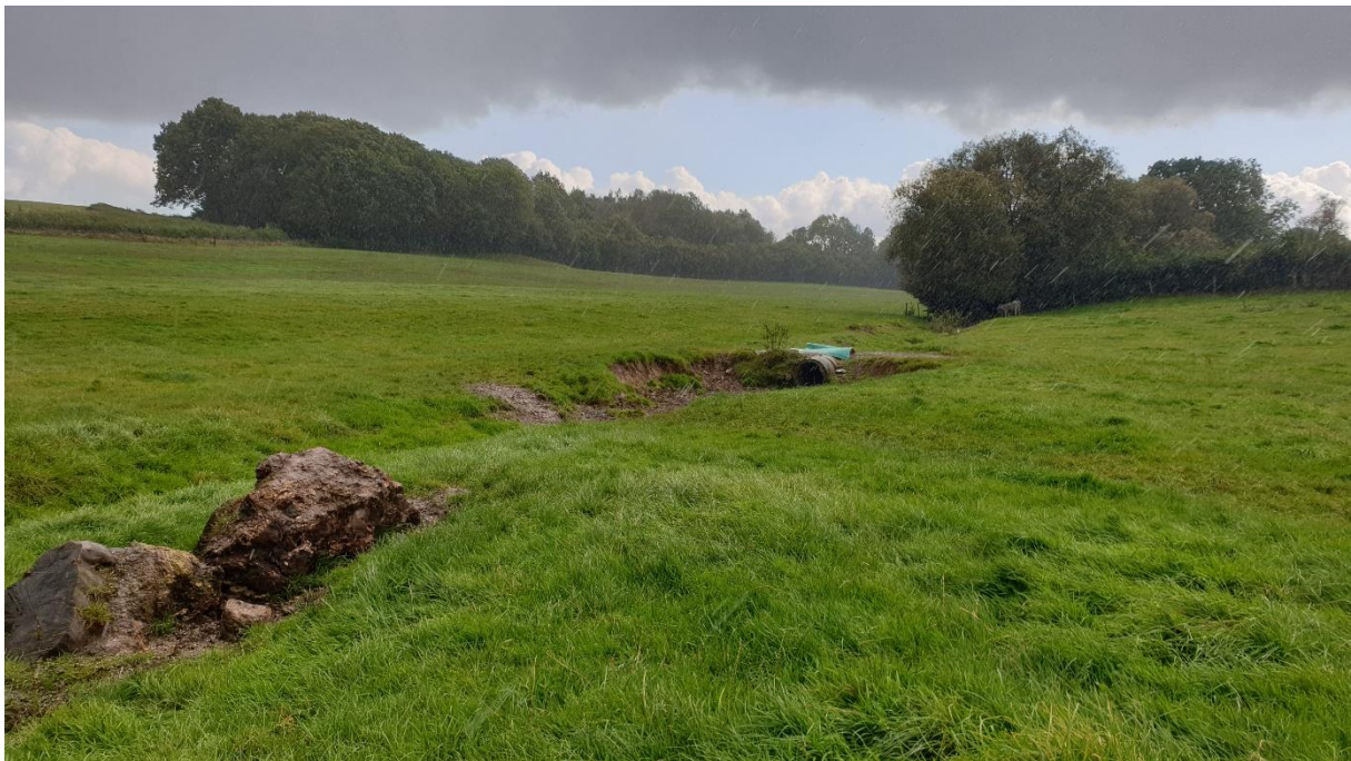
Figuur 6: Wegen in hellingen en drainage systemen onderscheppen sub surface flow, waarna het oppervlakkig afstroomt en versnelt het gebied verlaat. Deze drainagegeul ligt in de Hohnbach bovenstrooms in het Geul stroomgebied.
