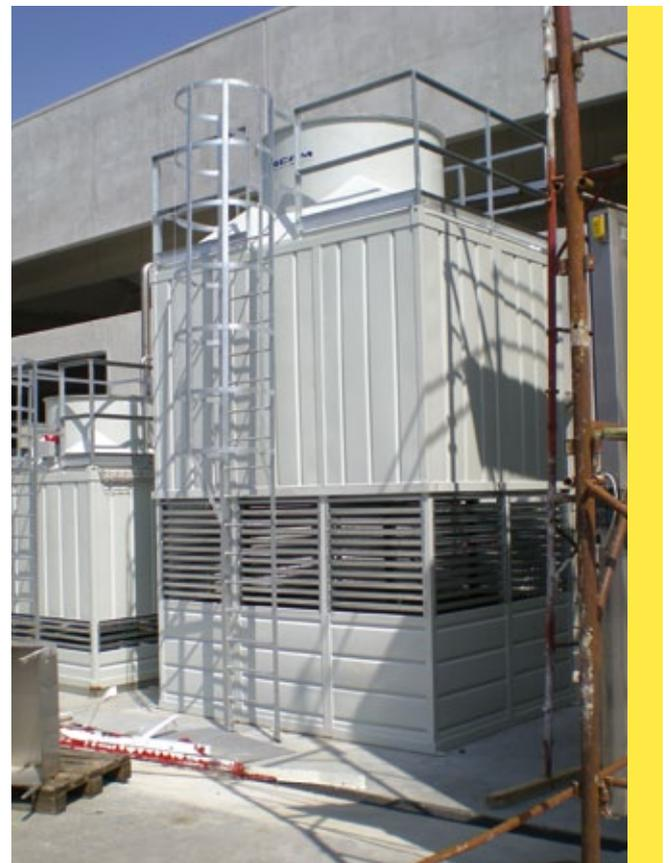
I sistemi di dispersione per le torri destinate all'industria alimentare in genere, ed ai concentratori in particolare, che riciclorano acqua contenente solidi sospesi, hanno caratteristiche di antintasamento con dispersione ad ampi passaggi per evitare che l'acqua proveniente dai condensatori a miscela intasi il sistema, riducendone le prestazioni.
