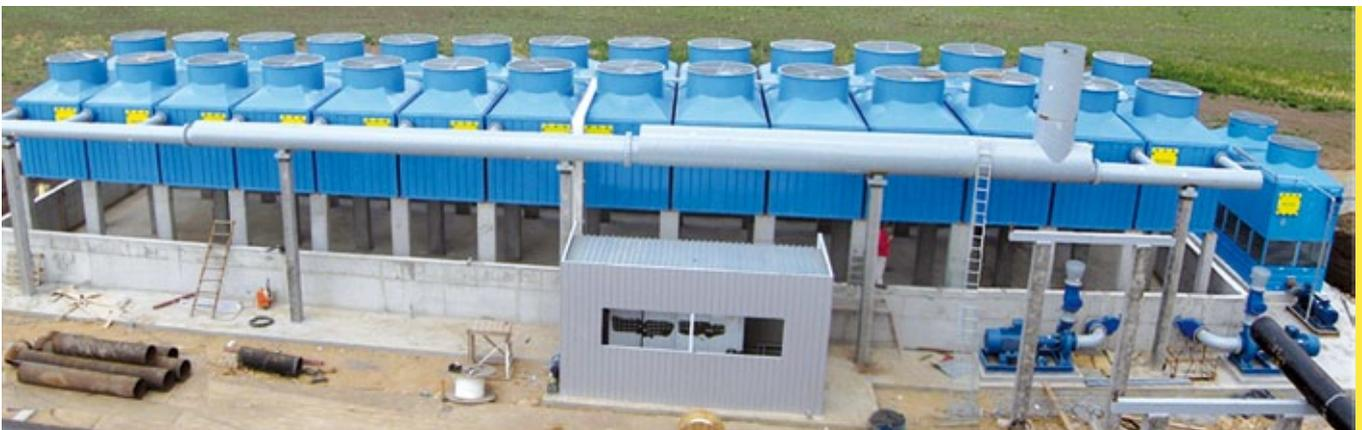
Corpi monolitici realizzati da lamierati uniti con saldature continue, senza giunzioni sintetiche, garantiscono oltre ad una robustezza strutturale anche l'esclusione di perdite dovute a modesti danneggiamenti in corso di trasporto o di assemblaggio, sono i pregi particolarmente apprezzati da questa serie di torri.
