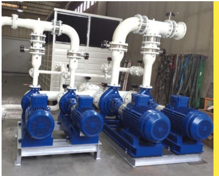
SISTEMA SWT1 INDIPENDENTE DI TRATTAMENTO ACQUA (ANTINCROSTANTE E BIOCIDA) E DI SPURGO AUTOMATICO A MEZZO DELLA CENTRALINA SCAM/WCNT.
