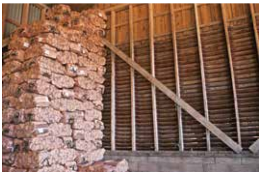
Lagerbygningen er avdelt i to haller, deleveggen har skråtmontert panel slik at det blir god lufting i vedhallen.
