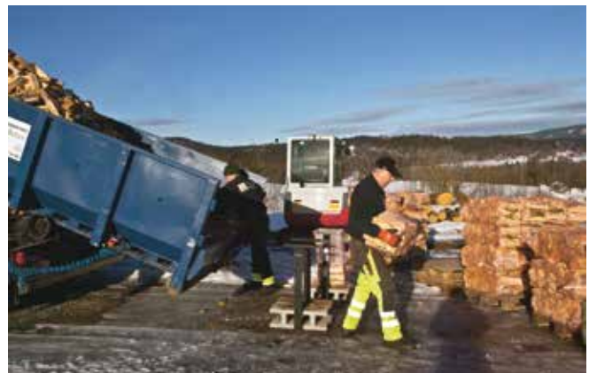
Planet til en lastebil med tipp benyttes som stablebord. Ei stålrive er effektiv for å få ned kubbene.
