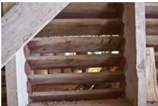
Lagerbygningen er avdelt i to haller, deleveggen har skråtmontert panel slik at det blir god lufting i vedhallen.
