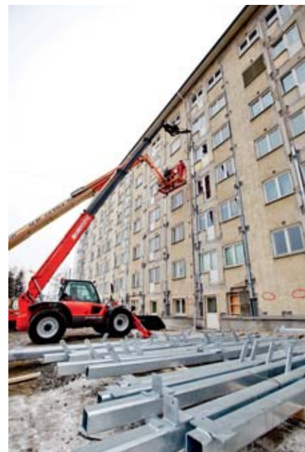
VEDLIKEHOLD: Fra tid til annen må det gjennomføres større eller mindre vedlikeholds- og rehabiliteringsarbeider i boligselskapene.
