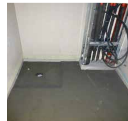
▲ PÅ Plass: Nedsenket dusjsone, varmekabler i støp, sveisemembran, vann og avløp i lukket sjakt. Det er blitt både branntett og vanntett mellom etasjene i Tårnbo, som tidligere har opplevd både vannlekkasjer og brann. (Foto: OBOS Prosjekt)
